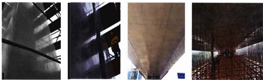
图 9.4-2 墩柱、箱梁施工的成品效果
