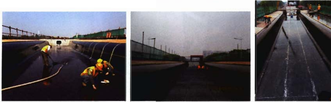
a) 连续梁绑扎钢筋前清洗 b) 箱梁底板钢筋绑扎 c) 简支标准段箱梁刷模板漆
